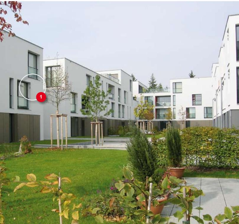
Verdeckter Fassadenabschluß mittels Fensterleibungslösung
