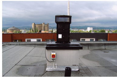
Die Abluftelemente der Serie 72 sind für den Betrieb mit dem Niederdruckventilator DVND 315 konzipiert worden (Hybridlüftung).
